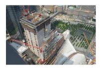
Der erste WOLFF in Manhattan: Weil der Bau des Betonkerns bereits weiter fortgeschritten ist als die Fassade, hat der WOLFF 700 B US (unten) wenig Platz. Dank seines besonders kurzen Gegenauslegers kann er sich trotzdem frei drehen.
